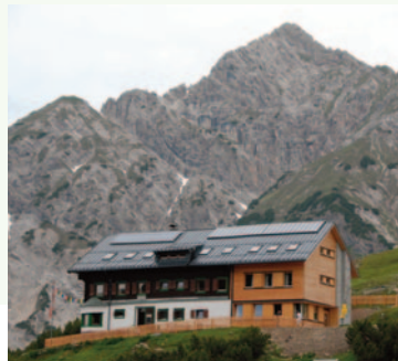
Die neue PV-Anlage sorgt für noch mehr Nachhaltigkeit im Hüttenbetrieb
